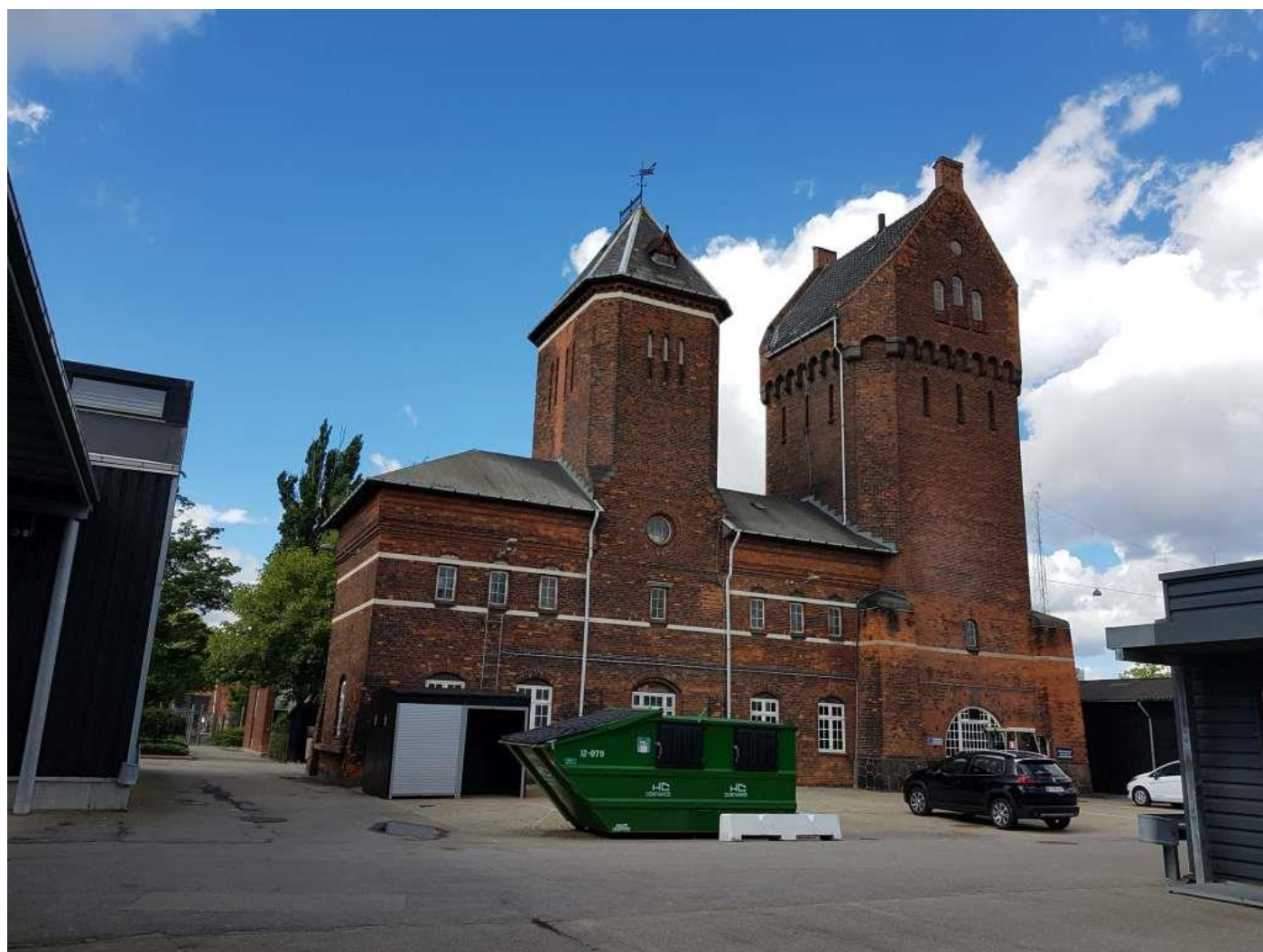
Vandtårn for Centralværkstedet Foto: Hans Henrik Landsvig (HHL)
